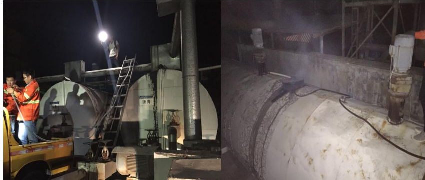
图C.4 油剂型易密实添加剂添加至沥青储存罐
